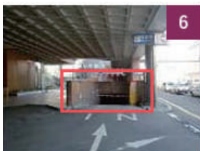
6 駐車場は地下になっております。フロントは2階です。(エレベーターでお上がりください)
